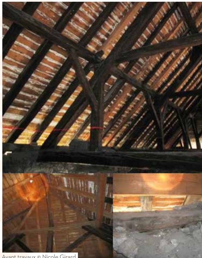
Avant travaux © Nicole Girard
