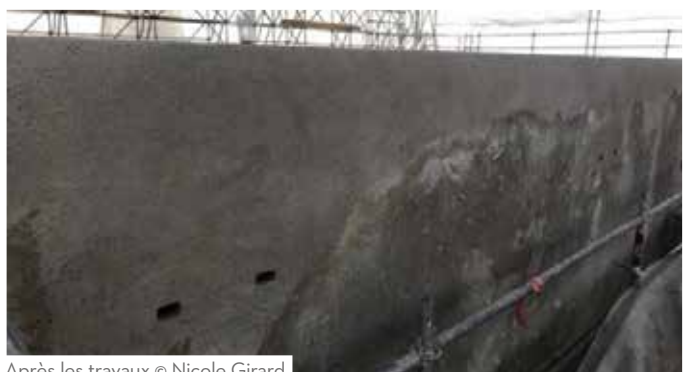
Après les travaux © Nicole Girard
