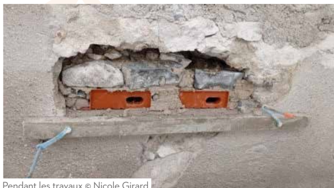
Pendant les travaux © Nicole Girard
