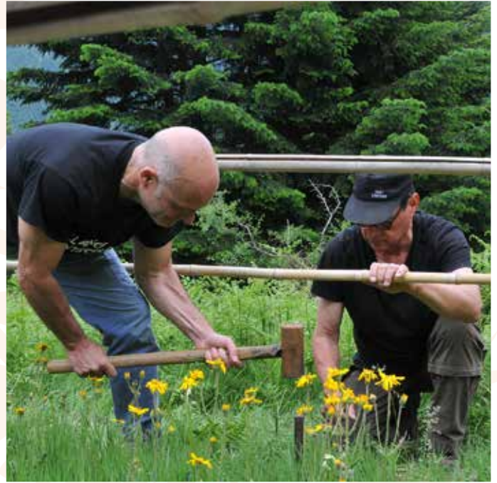
Mise en place d'une clôture pour protéger une station d'Arnica © LPO de la Loire
